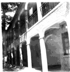
图五 办公室检验楼照片
