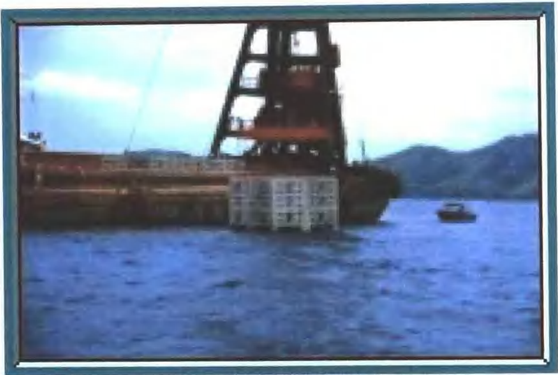
起重船在沉放钢筋混凝土鱼礁
