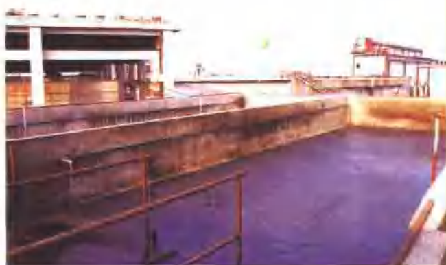
漳州糖厂造纸废水治理设施
