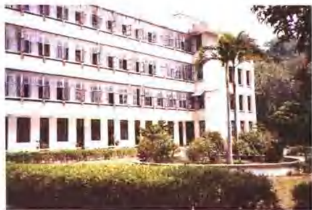
市环境监测综合楼(1986年市环保局从市府2号楼迁至此楼办公)
