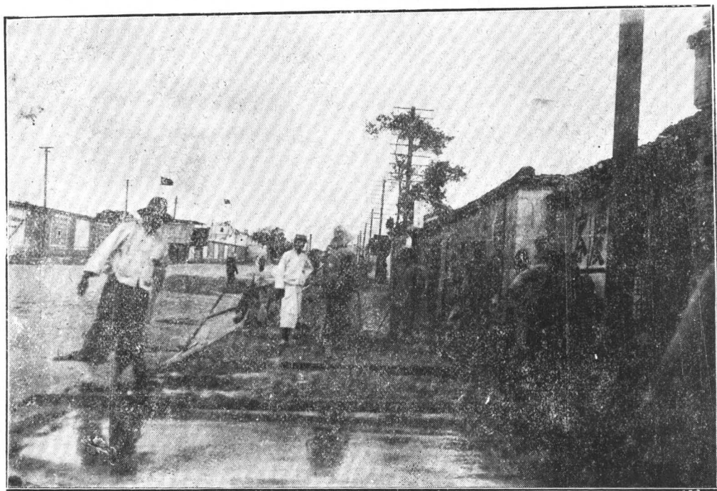
修築獅子巷行人道情形
