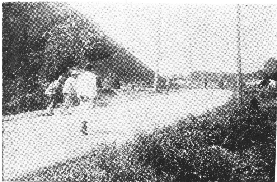
(五) 掘江門內平土山關路情況
