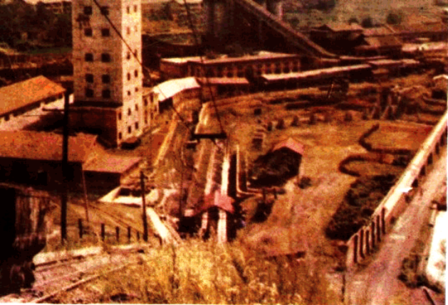
恩口煤矿一工区
