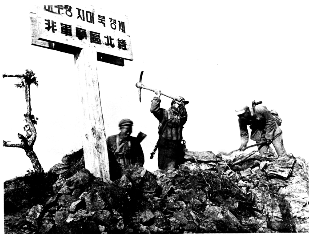
加築工事・1953・
