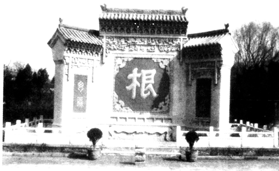
山西省洪洞县大槐树祭祖园大门内影壁
