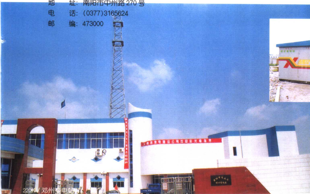
220KV 邓州变电站
