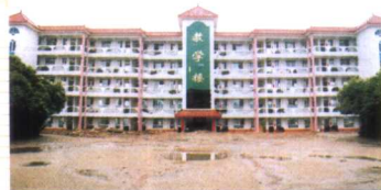
公司承建的市优工程—西峡县一高教学楼
