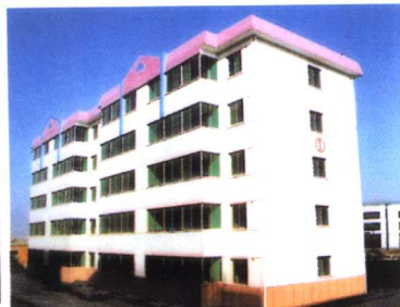
河南省光达集团有限公司1#住宅楼（南阳市“精品工程”）
