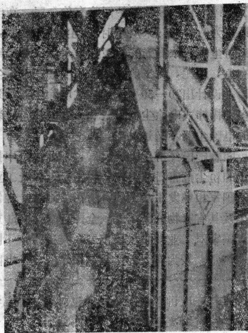
图4 横向极板的电除尘器
