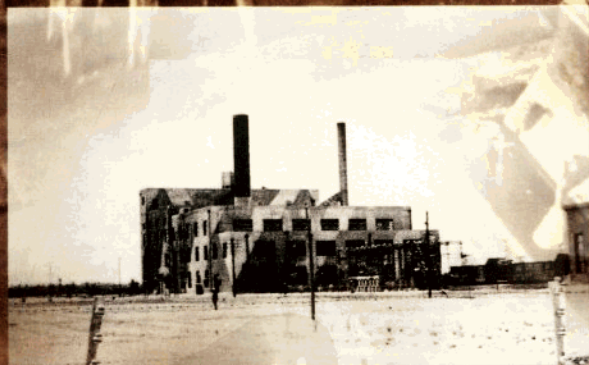
民国三十二年(1943年)淮南下窑(田家庵)第一发电所(厂房按2台6000千瓦建造, 实装1台2000千瓦机组)
