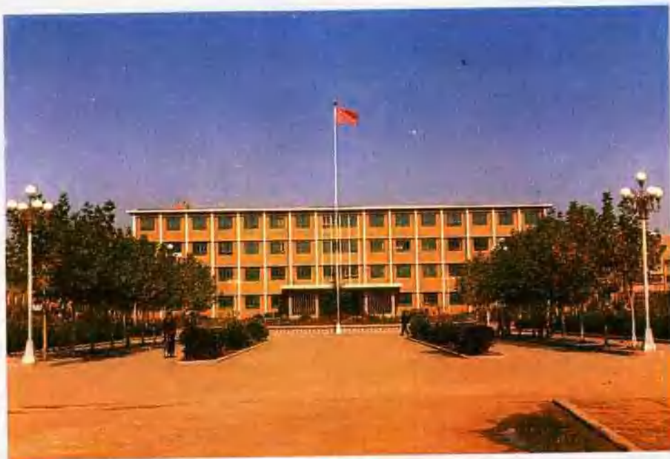
市委、市政府办公楼
