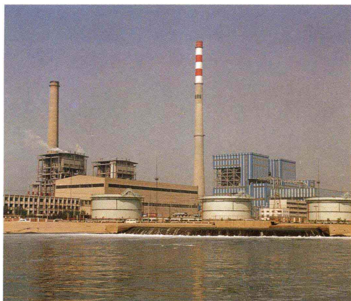
天津大港电厂 (4×320 兆瓦)
