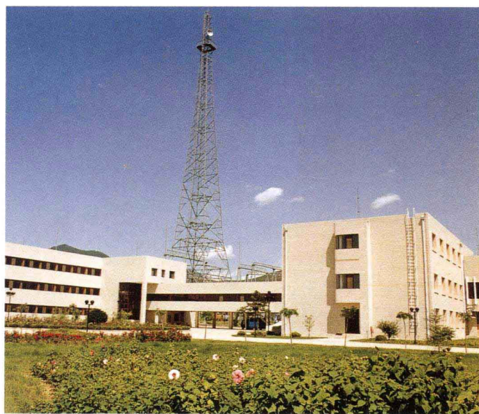
北京昌平 500 千伏变电站
