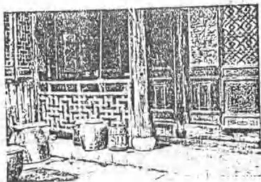
青翠巷故居內室
