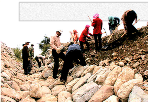
重建水利设施
