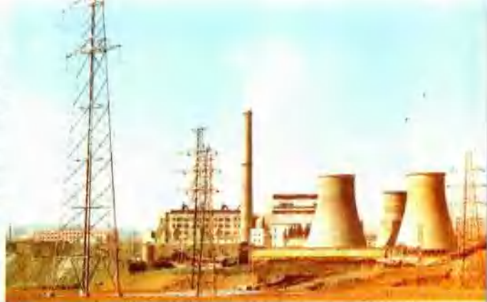
△建设中的鹤岗发电厂
