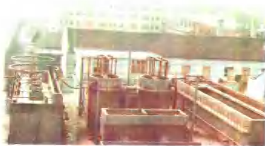
扬华公司设计施工的成都肉联厂污水处理站
