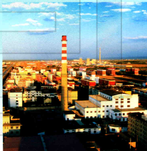
集中供热第一热源站
