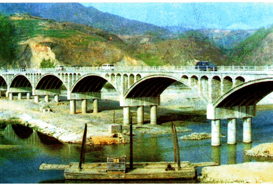
商南过风楼丹江大桥
