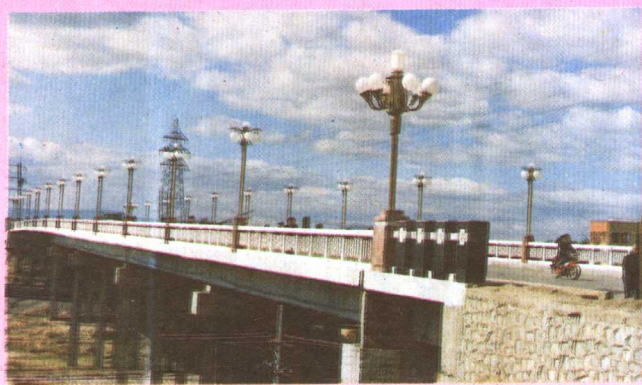
1987年竣工的第二跨线桥。
