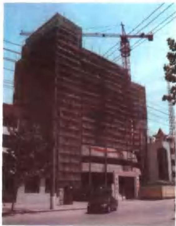
施工中的邯郸县城建局办公大楼
