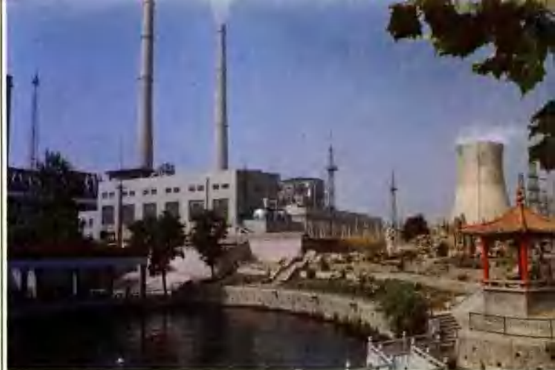
黄台发电厂 装机925MW
