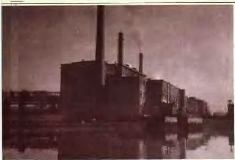
青岛发电厂 装机24MW
