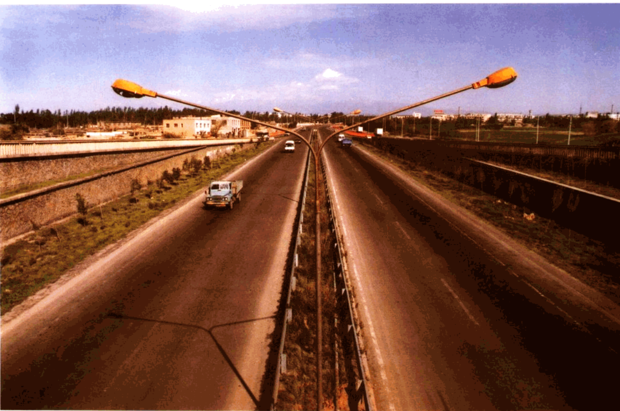
西出口一级公路
