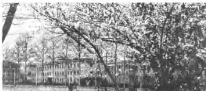
前: 善斋(即五院, 1932 年建); 后: 平斋(即七院, 1934 年建)
