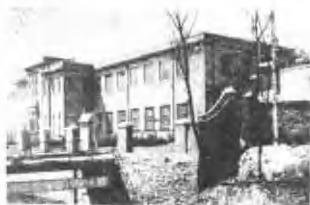
机械工程馆 (1934年建)
