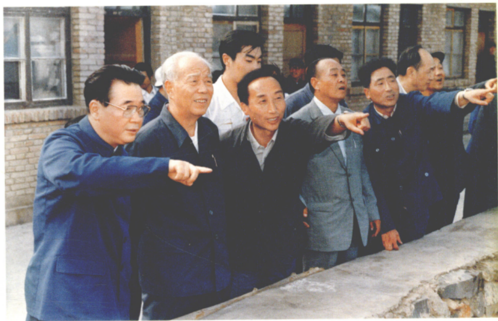
■ 1984年6月30日，李鹏（左一）与万里（左二）、陆佑楣（左三）、黄静波（左四）、黄毅诚（左六）在青海龙羊峡水电厂工地。
