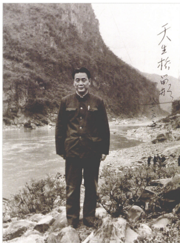
■ 1983年3月，李鹏在天生桥水电厂工地留影。
