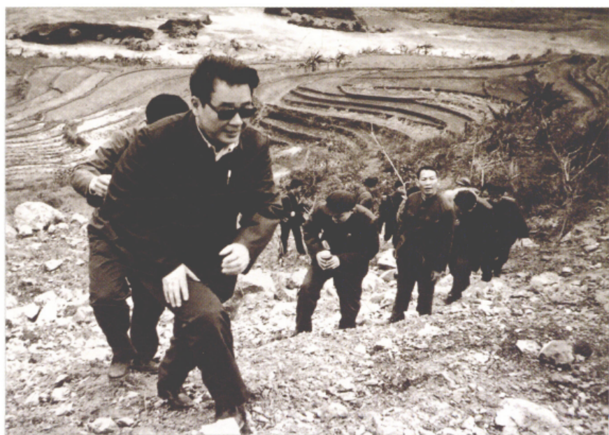
■ 1983年3月3日，李鹏考察天生桥二级水电厂工地。
