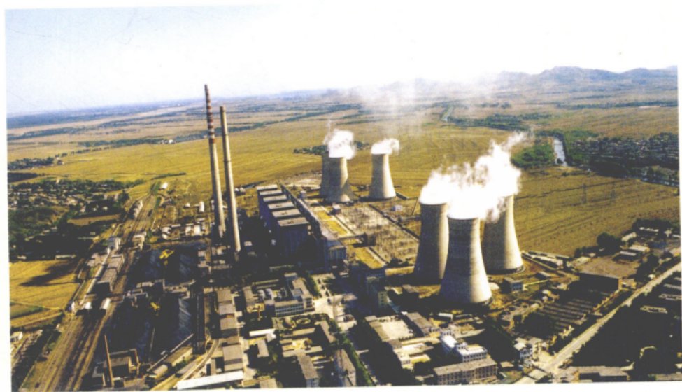
■ 锦州发电厂俯瞰。
