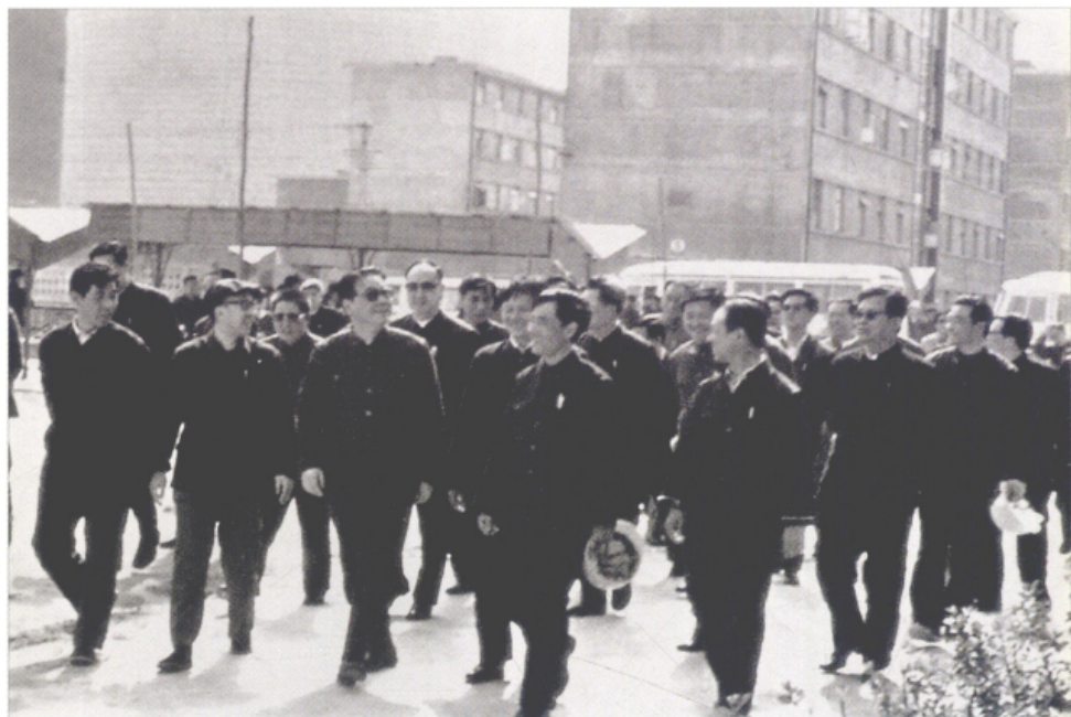
■ 1983 年 10 月 23 日,李鹏 (前排左三)视察邹县发电厂一期建设工地。
