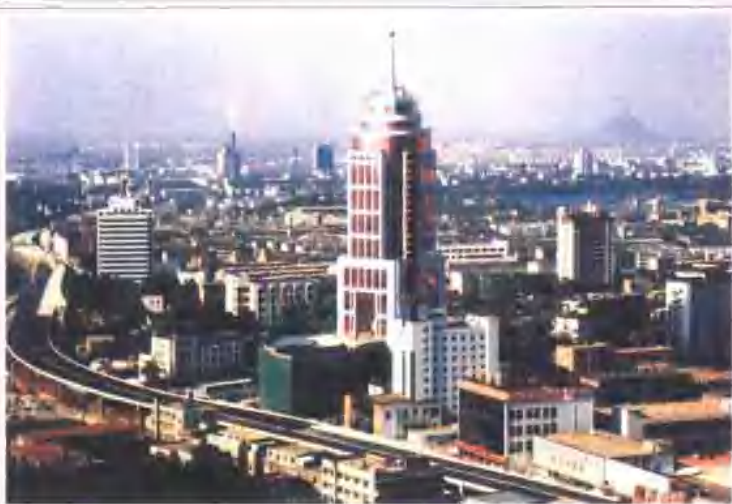
纵跨市区南北的高架桥，展现出济南城市建设正向现代化阔步前进。
