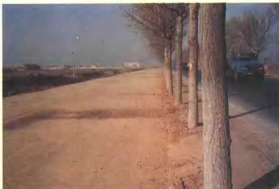
干线公路——潍高路广饶段（拓宽建设）
