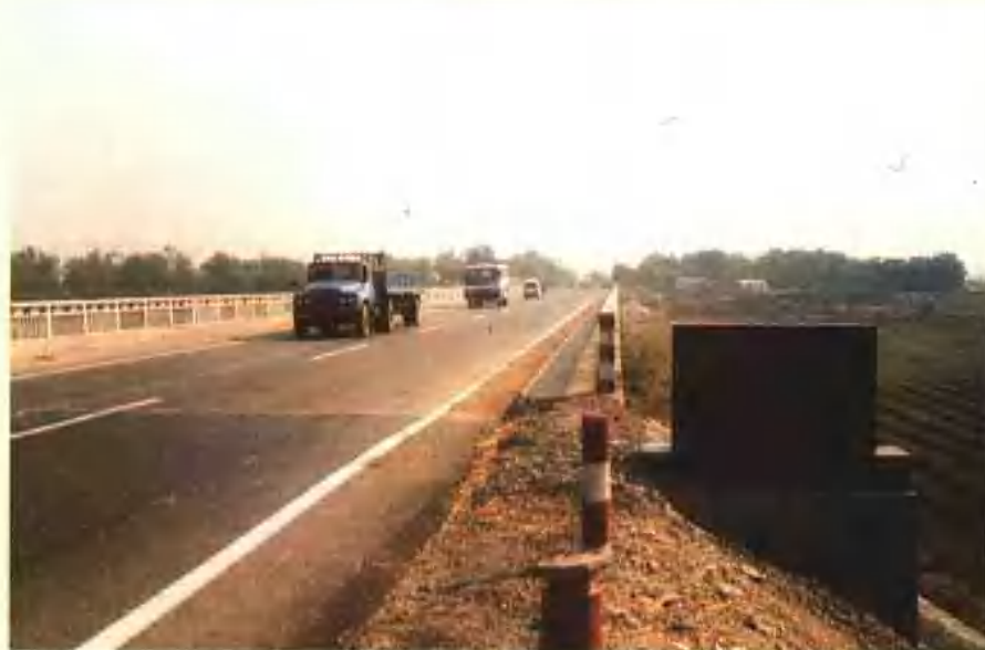
潍高路广饶段——淄河大桥
