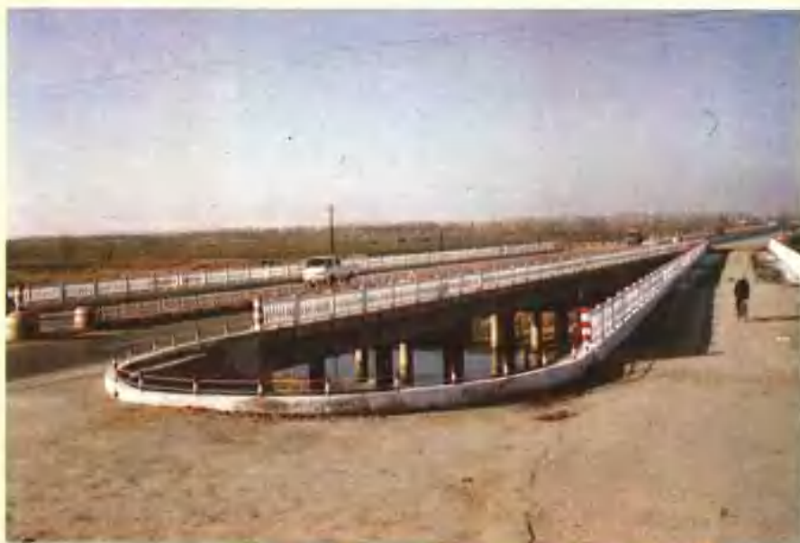
辛河路广饶段——小清河大桥
