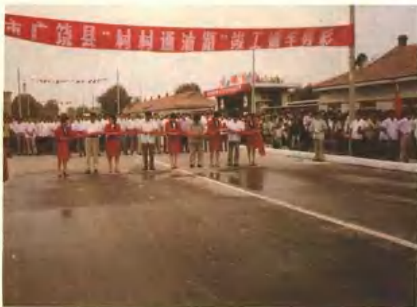
广饶县实现「村村通柏油路」竣工祝捷剪彩
