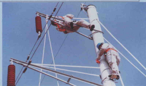
带电更换合成绝缘子
