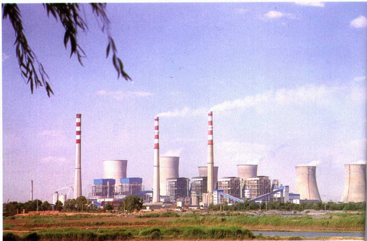
▲ 华能德州发电厂全貌装机 252 万千瓦。
