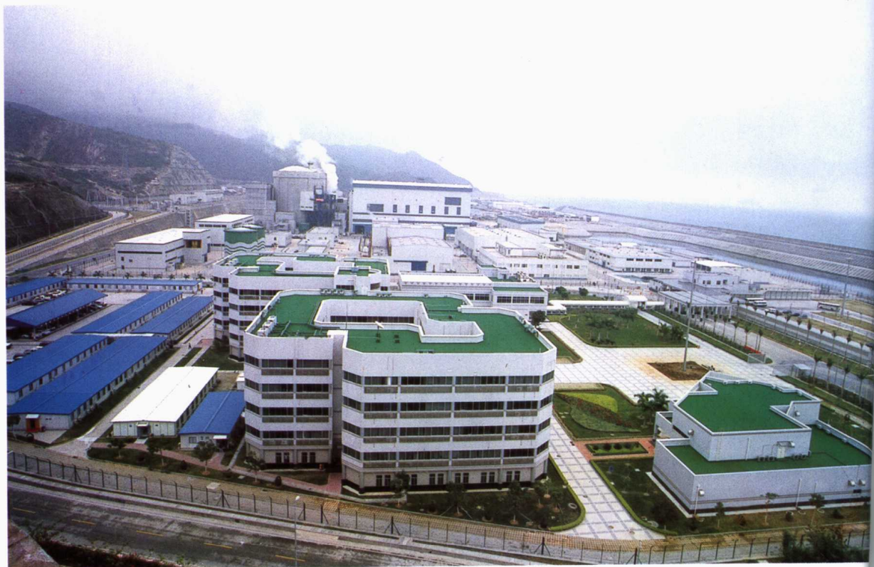
▲ 广东岭奥核电站全貌装机 200 万千瓦
