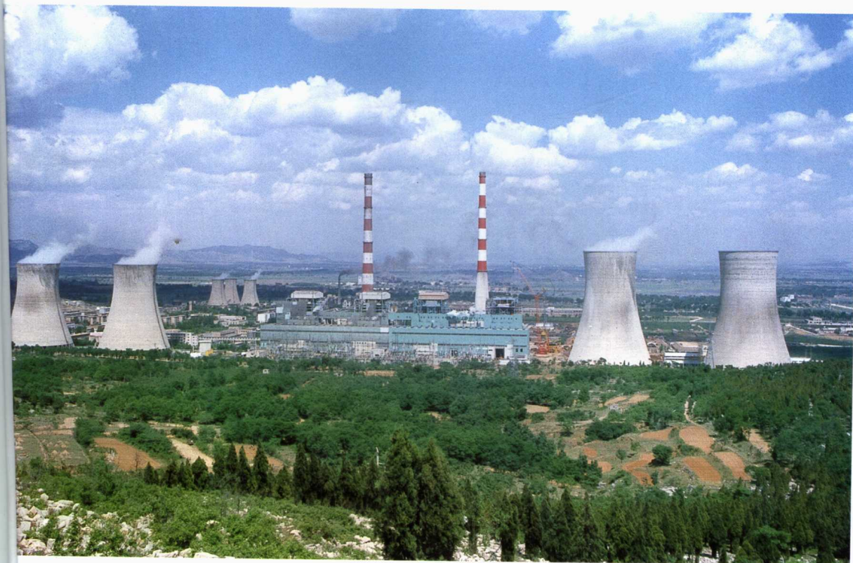
黄发电厂全貌装机 120 万千瓦。
