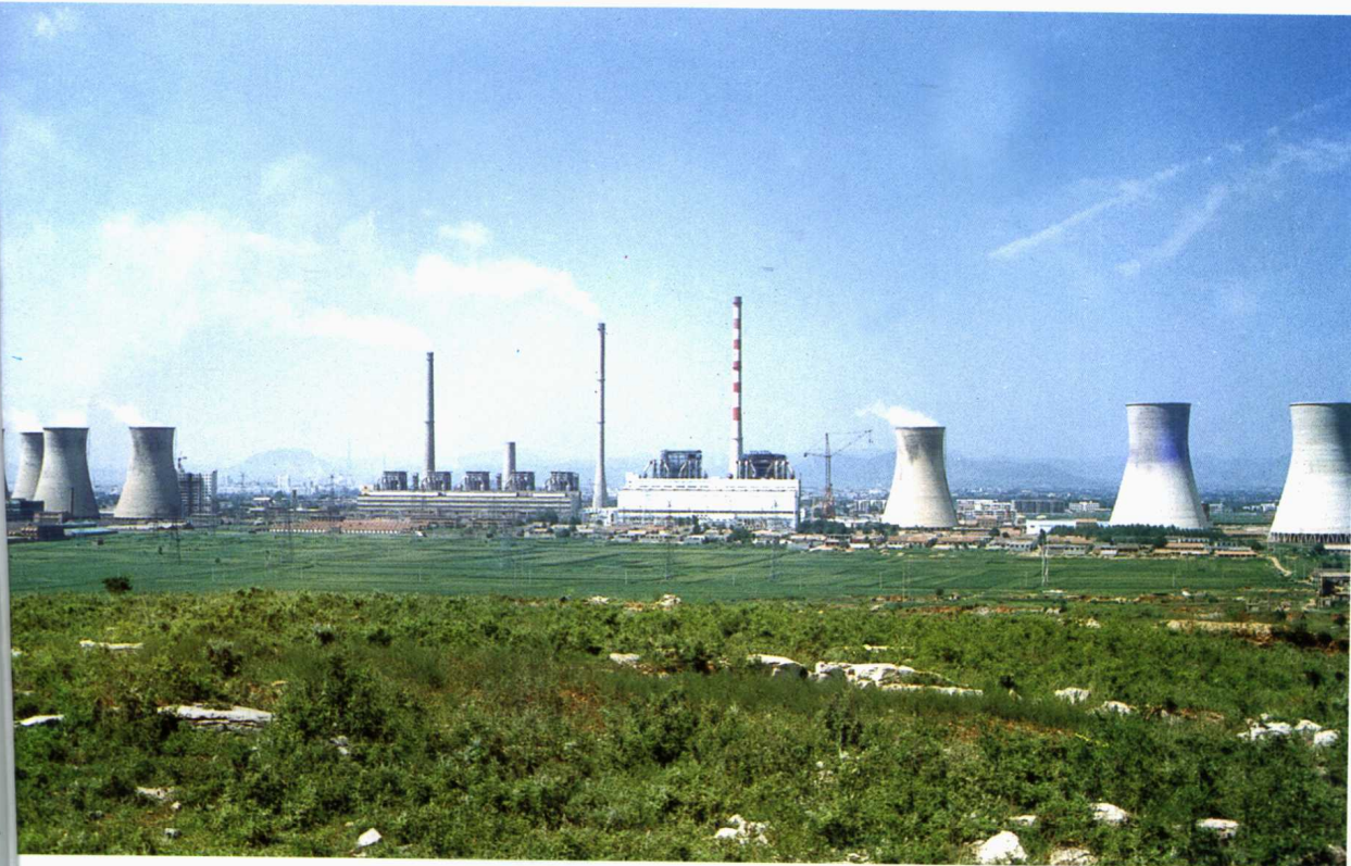
十里泉发电厂全貌装机 122.5 万千瓦。
