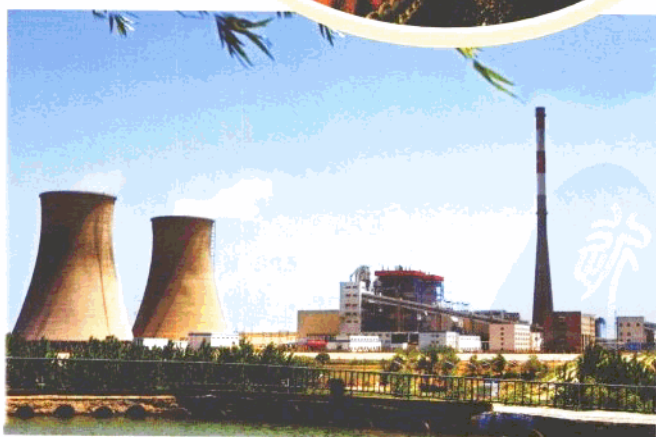
2 × 135 MW 循环经济热电厂
