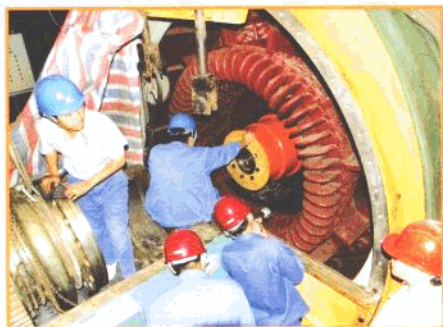
1#发电机转子吊装
