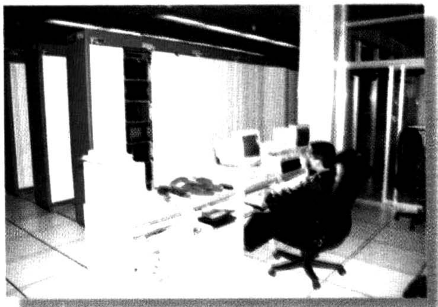
贵阳电信机房
