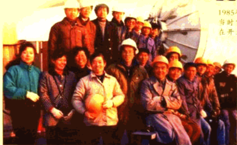
南通电视塔天馈工程完工后，全体参战人员在电视塔115米处合影。
