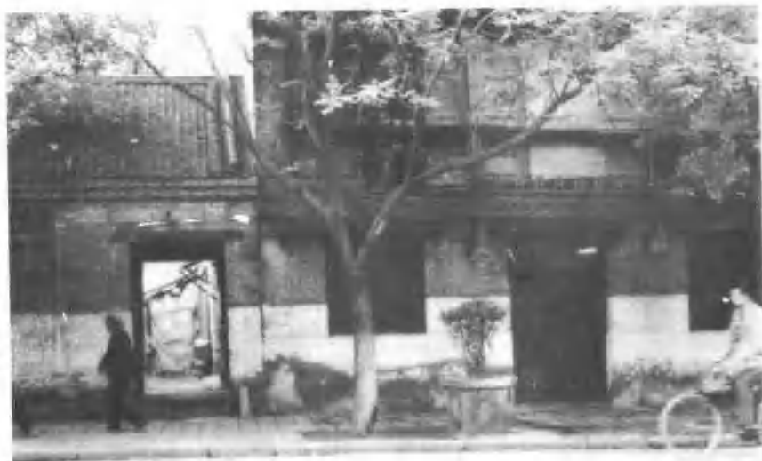
1953年10月18日成立河南省中医院，地址在开封市自由路47号
