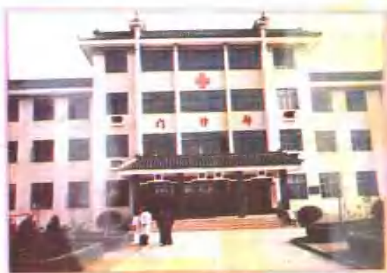
启东中医院门诊楼
