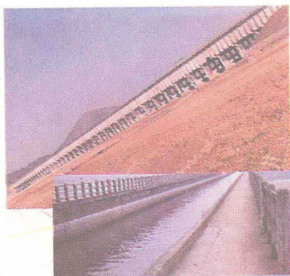
鮎鱼山灌区灌河渡槽
