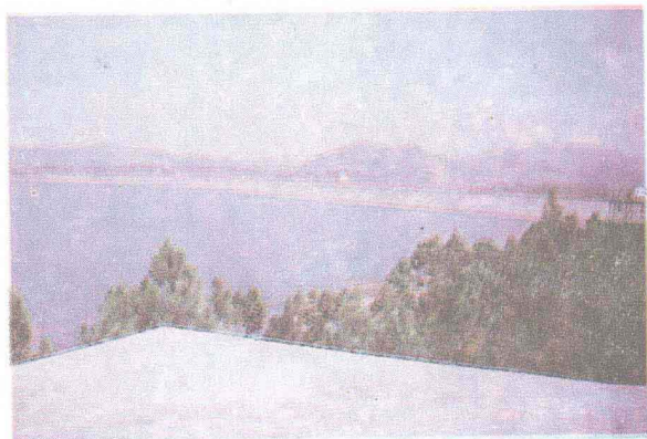
鮎鱼山水库大坝内坡远视
