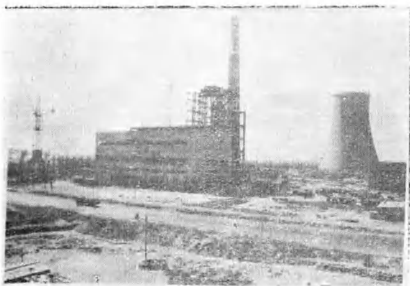
沙岭子电厂一期工程建设工地， 发电机组120万千瓦。
