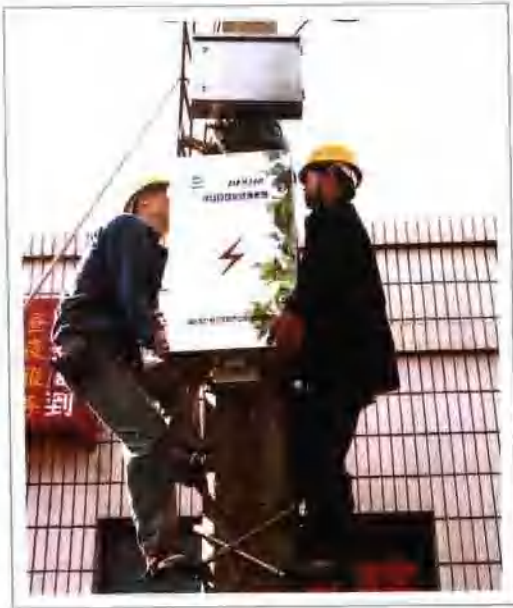
调配一体化安装
