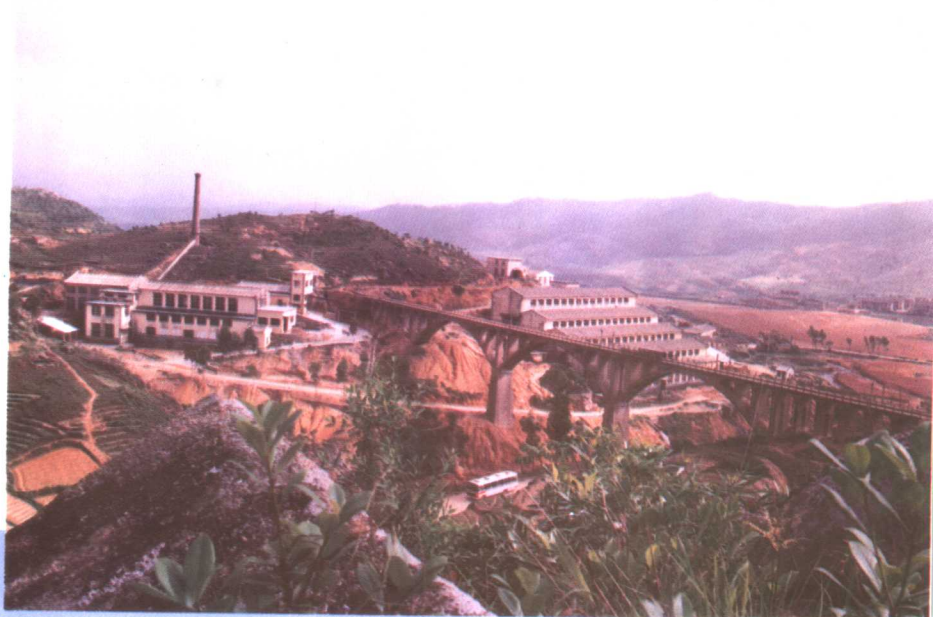
莲花山钨矿500 吨选厂 ▶
