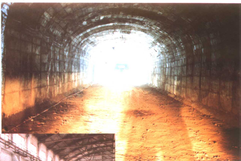
有色第十建设 公司承建的大 型隧道工程
