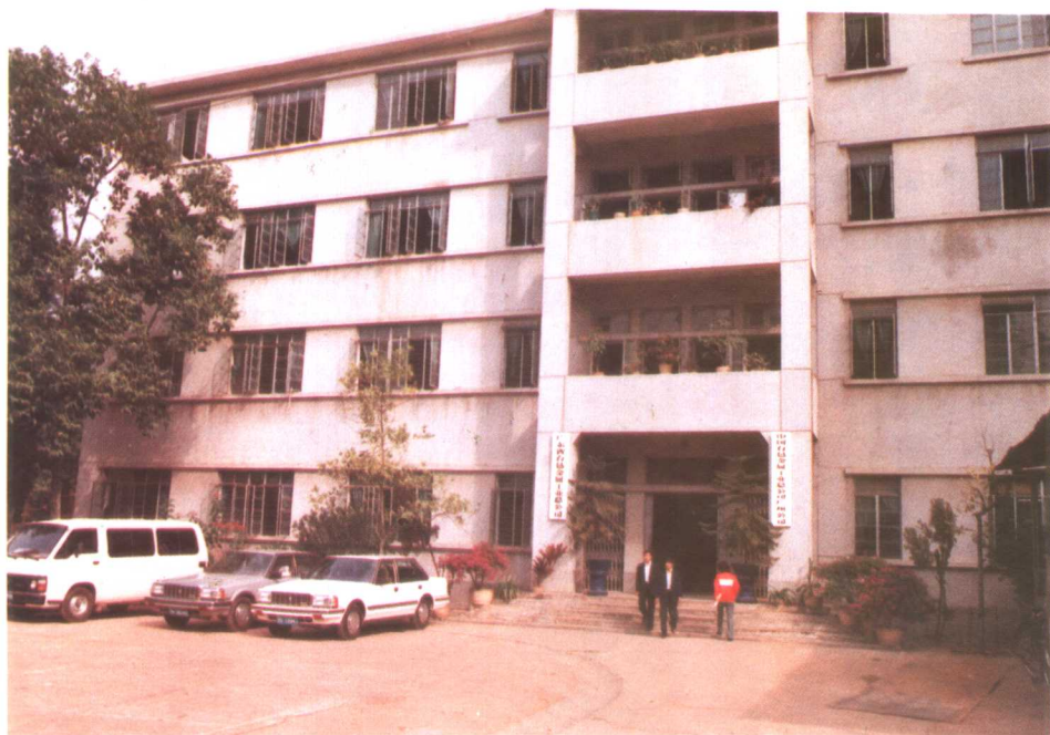
► 有色广州公司办公大楼
