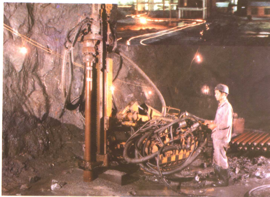
凡口铅锌矿 井下潜孔钻机 作业现场
