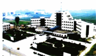
建设中的科技孵化器
