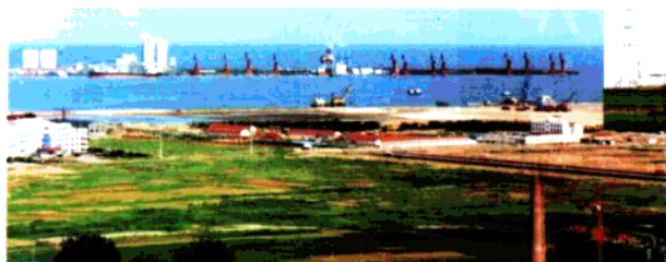
正在建设的木片码头一角
