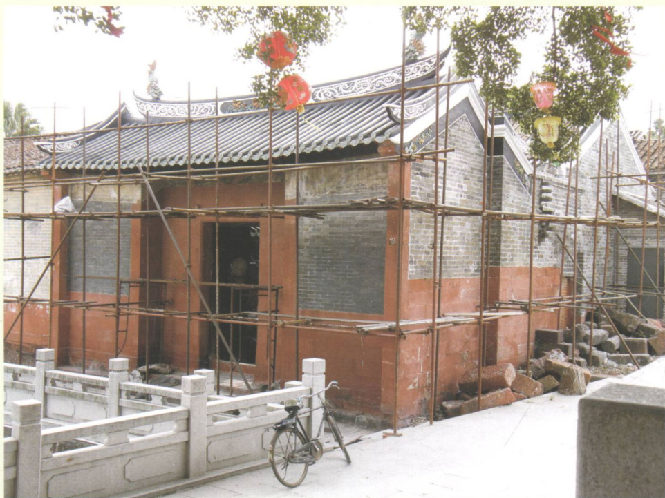
文物维修现场
