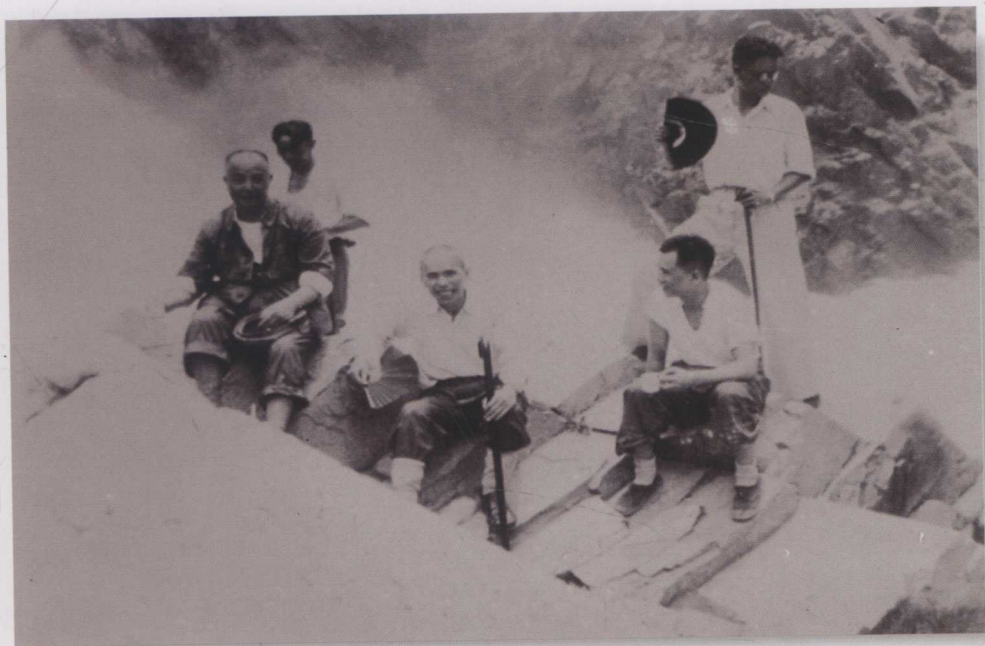
1950年夏，福建省委书记张鼎丞（中）和省长方毅（右二）、副省长陈绍宽（左一）等视察古田溪水电站工地
