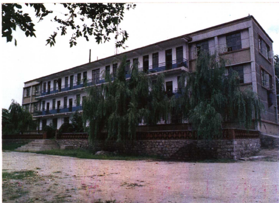
莱阳市公安局办公大楼
