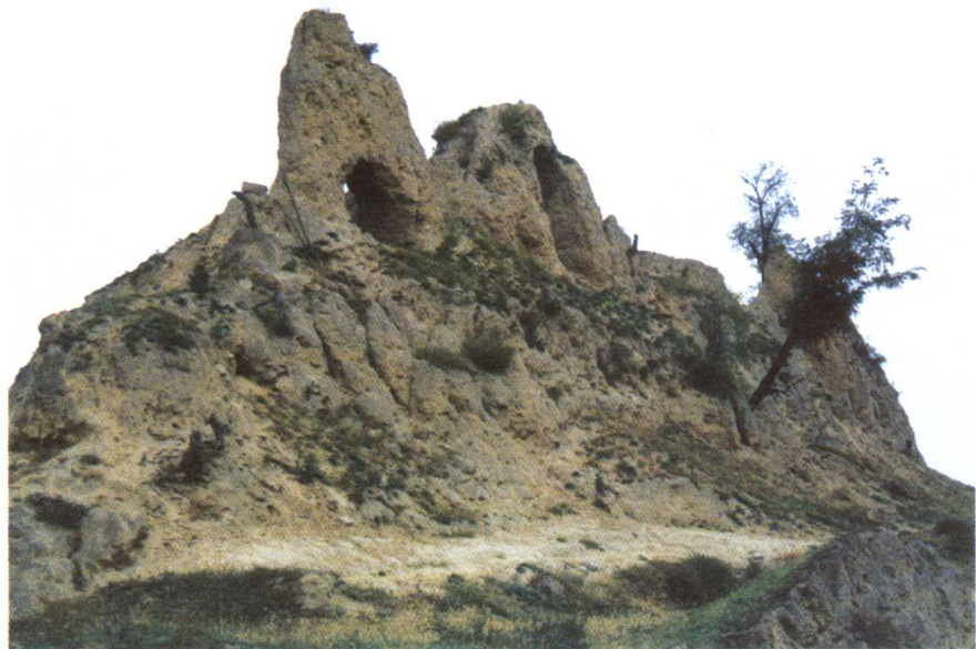
▲ 阆乡故城东南城墙一角
