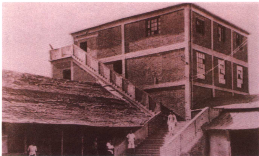
▲灵宝中华棉花机器打包股份有限公司（打包车间厂房）
