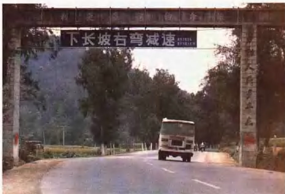
市交警支隊，惠安大隊在事故多發的324線惠安霞星溝路段，設置懸空監控標誌牌，提示：“下長坡右彎減速！”
