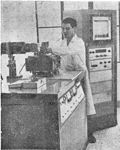
X光衍射仪正在安装调试
