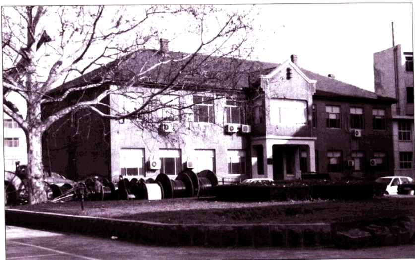
■ 青岛电业局潍坊电厂潍县转电所旧址，建于1954年（今潍城区青年路18号）
