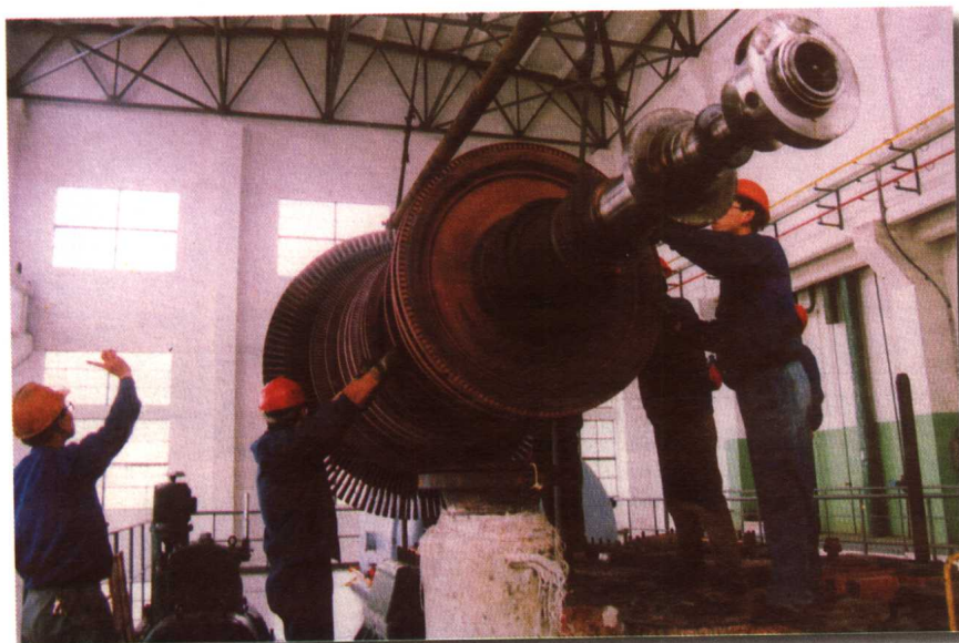
热电厂工人在安装机组
