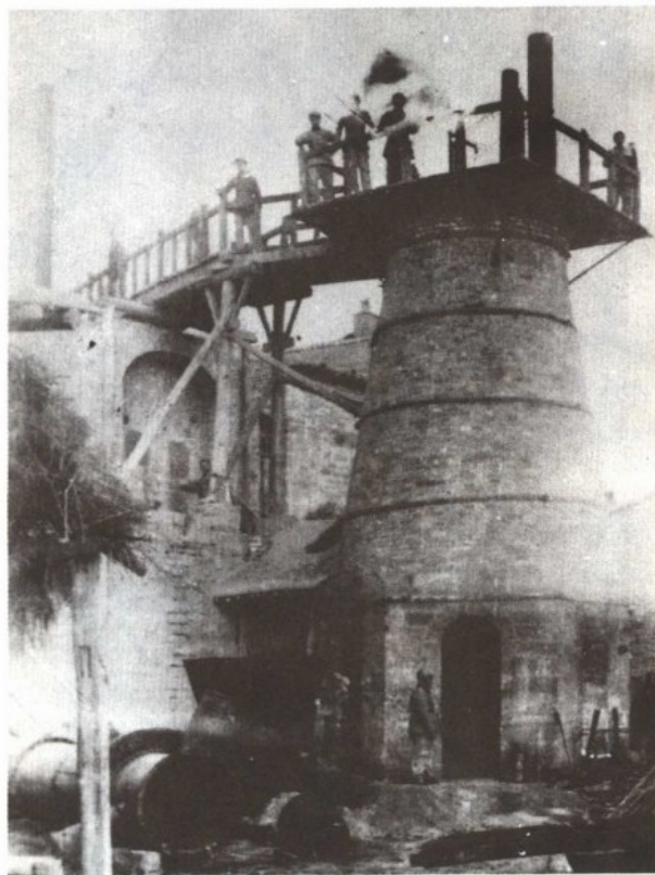
晋绥边区招贤镇铁厂（即晋绥兵工七厂）的日产一吨灰生铁的小高炉
