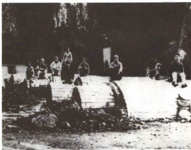
柳沟铁厂的弹壳焖火炉
