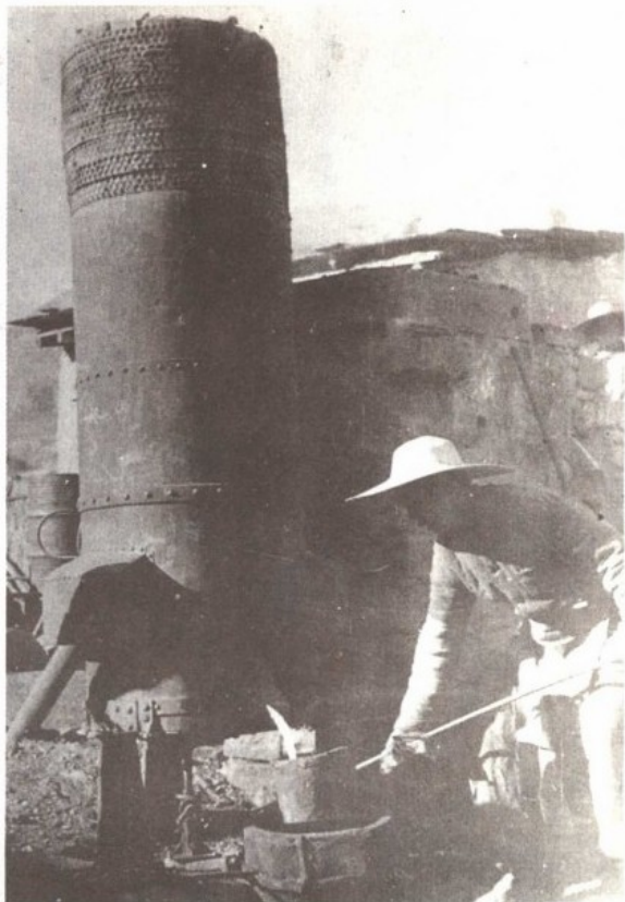
延安兵工厂的三节式化铁炉在出铁水
