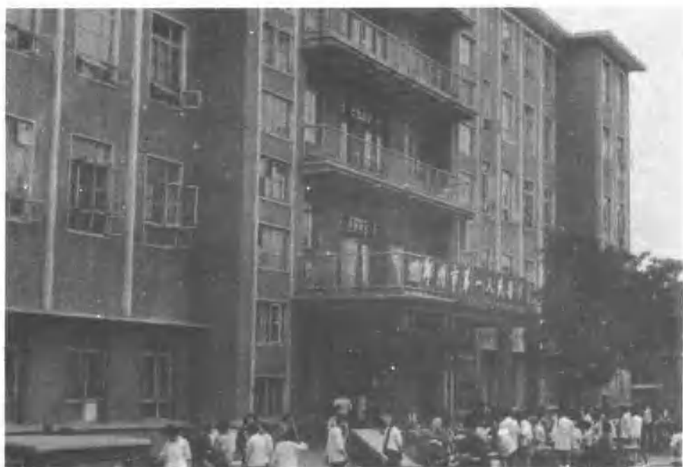
门诊大楼 (1978年建成, 建筑面积4850 m 2 )
