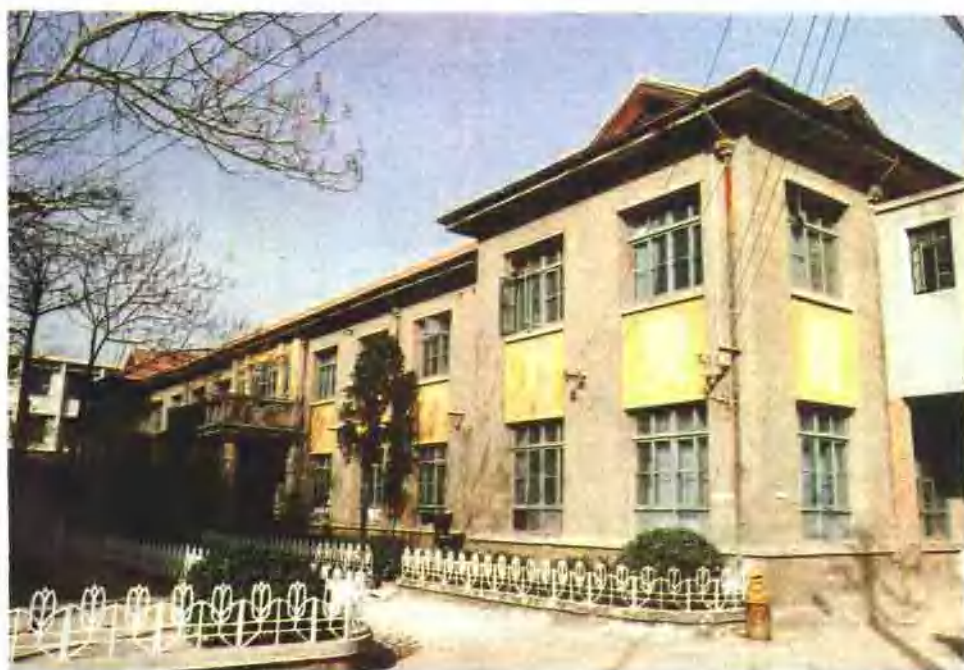
内科病房楼 (1953年建成, 建筑面积1488.5 m 2 )
