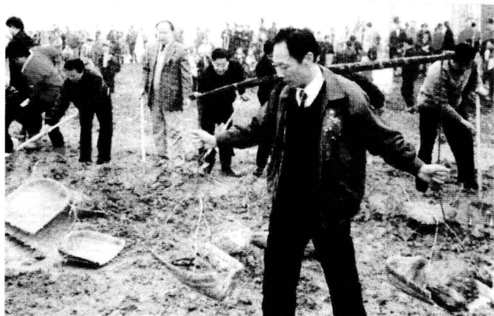
江夏区委书记李传德等同志参加老区抗旱补源工程工 地劳动。
