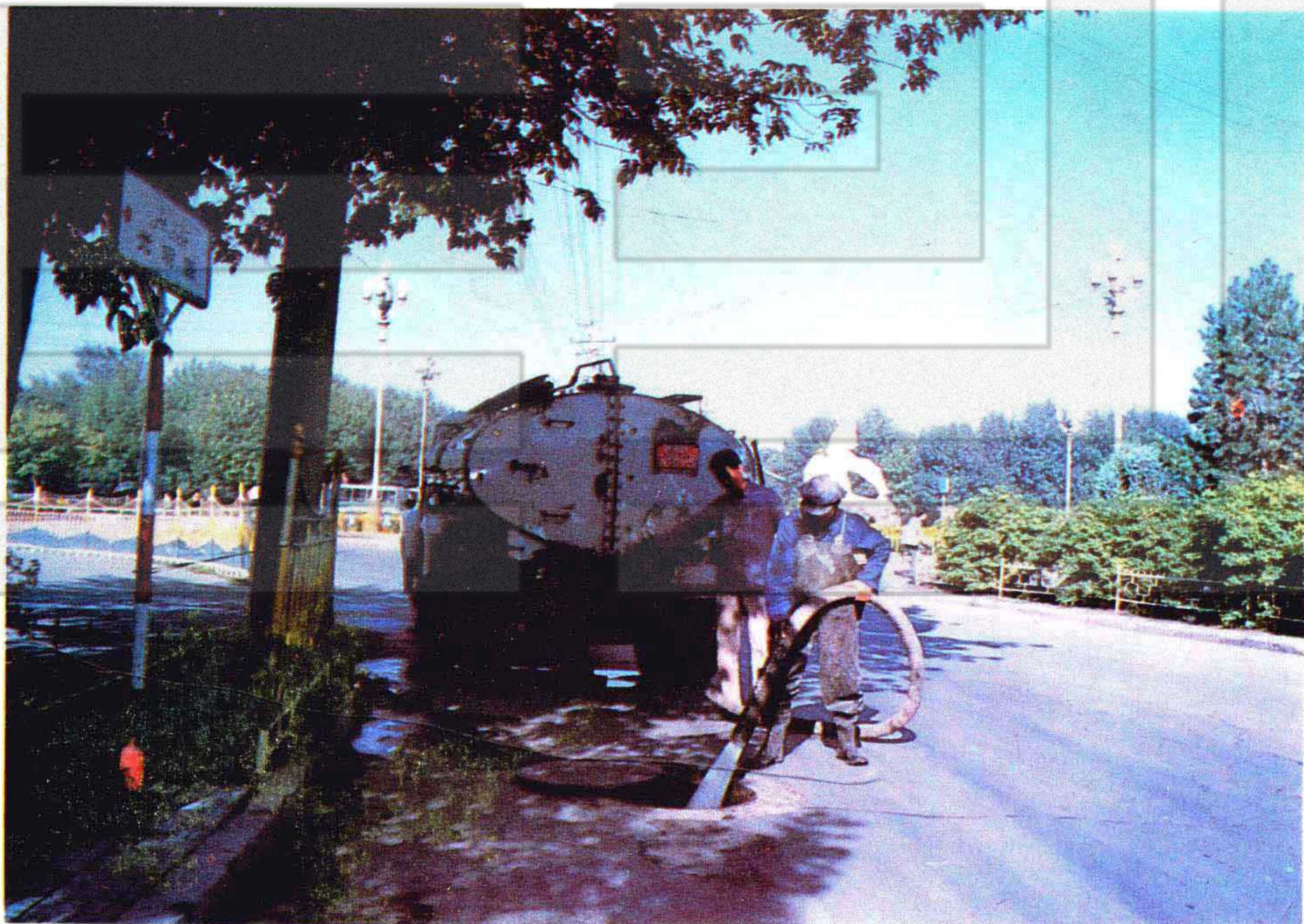
高压水车疏通下水管道
